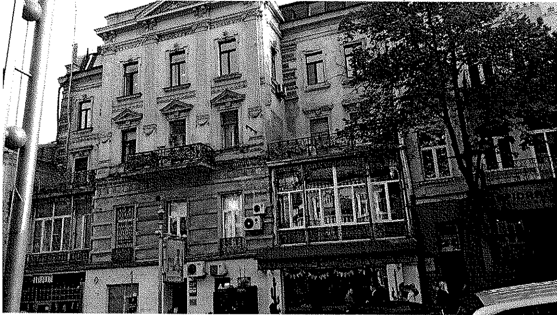
Загальний вид будинку №23А по вул.Прорізна з головного фасаду
